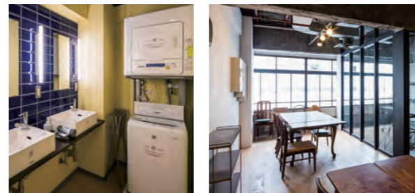
2階ゲストハウス(左)と3階多目的レンタルスペース(右) 水まわり設備から家電に至るまでパナソニック製品で統一。
