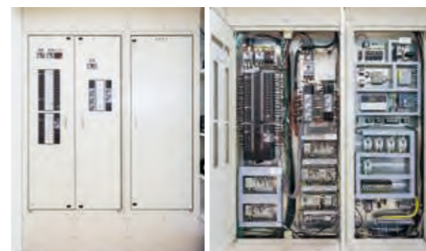
電灯回路、動力回路、BEMSシステムが一体となった分電盤をオーダーで製作。操作性や「見える化・見せる化」を考慮し、扉がフルオープンできる場所に設置されました。
