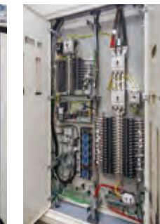
多回路エネルギーモニタとフル2線式リモコン(照明制御)
