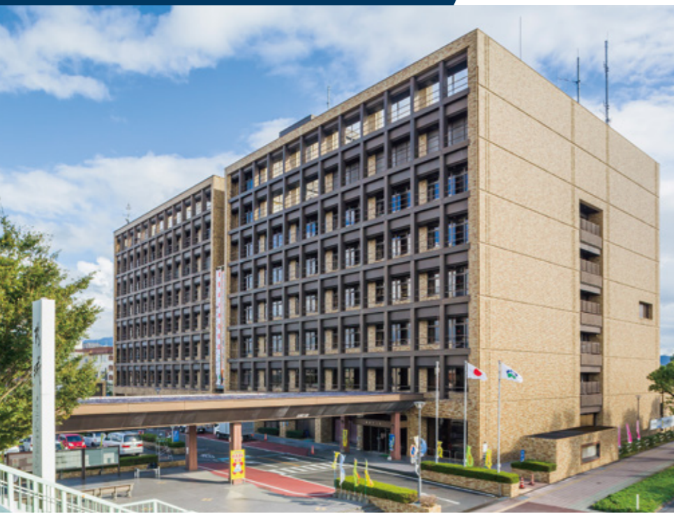
本庁舎本館・南別館:LED照明と高効率空調、エマネージの導入により年間CO 2 排出量187.1tを削減。
