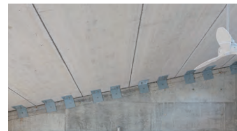
室内から見た屋根裏。屋根材にはスパンクリート(軽量のプレキャストコンクリート)を使用。
