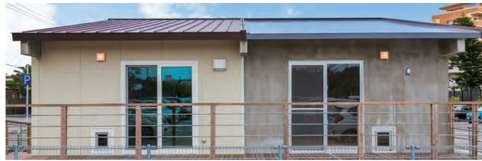
バルコニー側から見たとき。右側が沖縄の一般的な住宅であるRC・コンクリートブロック造、左側はコンクリートブロックの上から外張り断熱を施している。
