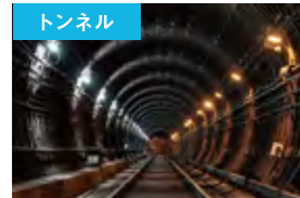
長距離トンネル内の通信手段に
