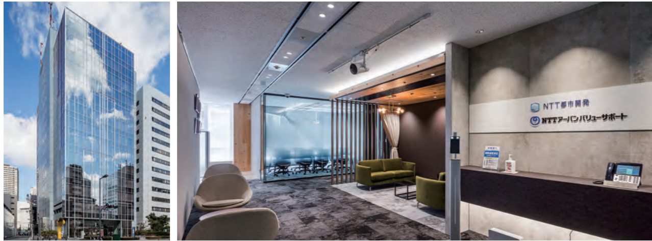
NTT都市開発様とNTTアーバンバリューサポート様が入居されているビル外観(左)。受付(右)にはスペースプレーヤーを設置。
