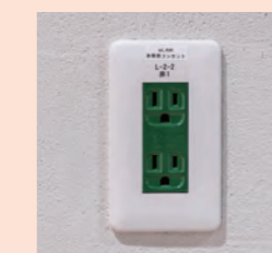
EVと連携し、災害時に利用できるコンセント
