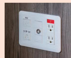
コージェネレーションシステムと連携し、災害時に使用できるコンセント
