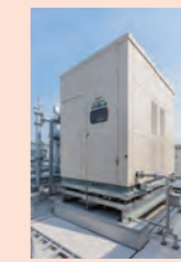
廃熱投入型吸収式冷水機
