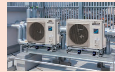
電気ヒートポンプエアコン室外機
