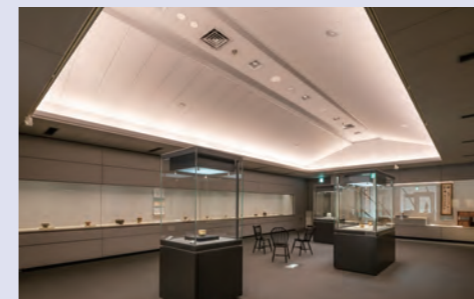
島根を代表する工芸品のコレクション展示室。今回のリニューアルで間接照明とダウンライトをLED化。マルチマネージャExを使用して、展示作品の一点一点に合わせた調光をしています。
