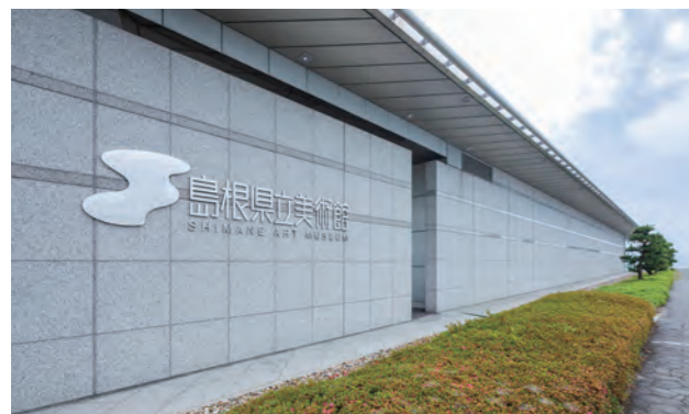
島根県立美術館 湖岸側 採用商品: 軒下用LEDダウンライト(指定色塗装)
