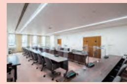
庁舎内に併設されている全員協議会室にはSmartArchiの薄光パネルタイプのベースライトを採用。
