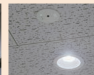
WiLIAのダウンライトが整然と並ぶ2階廊下。従業員の出勤退勤時間に合わせて明るさをコントロールしています。
