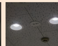
1階エントランス近くの廊下には、人感センサ付きのダウンライトを設置。明るさ0%から突然100%に点灯すると驚く人もいるため、あえてほのかに点灯させています。
