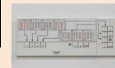
応接室の照明はライトマネージャー-Fxでコントロール。最大8シーンまで設定でき、ひと目でわかるように表示されています。
