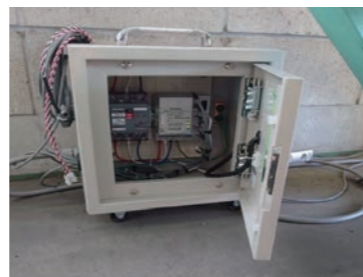
自社で製作された移動式のエネルギーモニター。測定したい場所へお客様ご自身で移動、測定することが可能。
