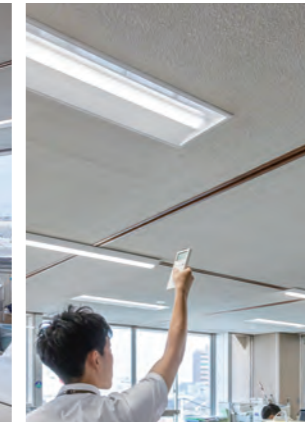
執務室はPIpit調光シリーズのLEDベースライトをご採用。昼光センサを組み合わせ、自動で一定の明るさに調光。タイム設定で17時半以降は照度を60%に落としています。さらにハンディライコンを使って調光したい器具に向けて個別に操作することも可能なため、不在席の頭上のみ消灯するなど、細かな省エネが可能です。
