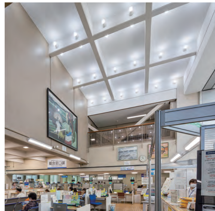
1階エントランスホールの吹き抜けは、大空間の雰囲気を損なわないように、オリジナルの光源に近付けるよう選択してLED化を実現しています。
