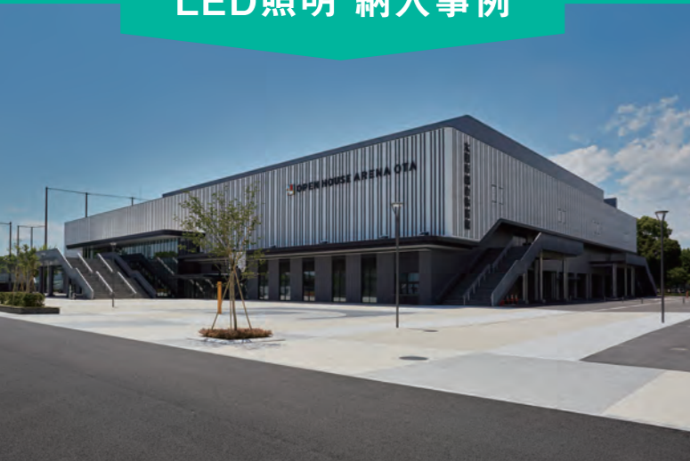
オープンハウスアリーナ太田 外観 採用商品:LED投光器・LED街路灯
