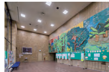
天井の高いエントランスホールにも十分な明るさのLEDスクエアベースライトをご採用。
