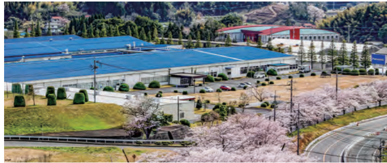
パナソニック ソーラーシステム製造株式会社 外観
