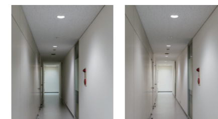
ひと(熱線)センサ付ダウンライト 2階廊下は人がいなくなると3分後に自動消灯するよう設定
