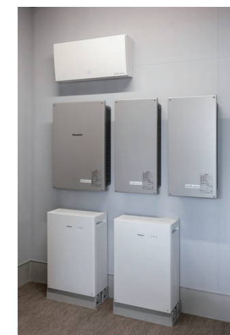
上:スマートコスモ分電盤 中央:パワーステーション 下:リチウムイオン蓄電池ユニット
