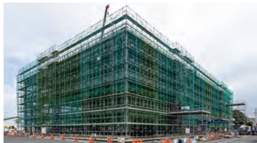
建設中の新社屋
