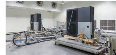
パナソニック群馬工場のA2W/チラー試験室にてマイナス15℃の環境で試験中の様子
