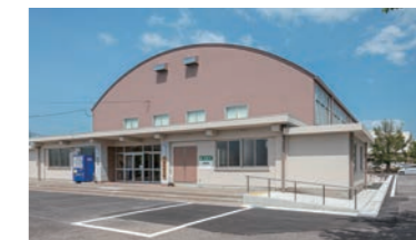
令和6年 町立体育館(他2施設)
