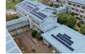
太陽光発電システム
