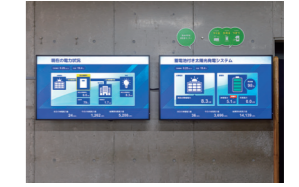
発電量モニター
