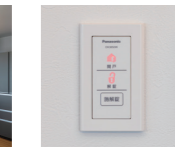
電気錠操作押釦。鍵を使わず部屋から玄関ドアを操作できる。
