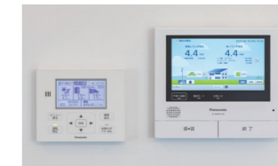
室内のネットリモコン(左)からEVへの充電操作が可能。インターホンのモニター(右)でも発電状況や電気の使用状況がわかる。
