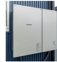
左:パワーステーション 右:コンバータ
