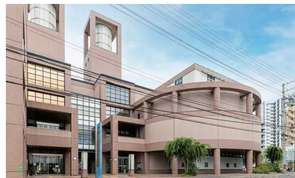
安芸区総合福祉センター 外観
