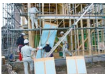
「くるみーな壁パネル」を施工中の様子。合板と断熱材が一体化しているため、配置にもミスがない。
