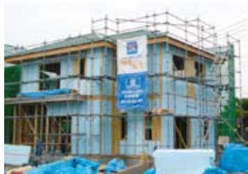
断熱材ですつぱりと覆われた外観。くぎ打ちをした後にパネルスパーをはめ込み、隙間をなくす。
