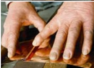
写真上/雨といの製作には、銅板を「ヒョウシギ」という木の道具で叩いて折り曲げる。写真下/ムダ折りという部分に銅板を接いでいく。折り加減や角度など、技は全て手に叩き込まれている。
