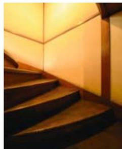
応接棟の階段部分。踏み板を弧状にして、上りやすさとデザイン性を兼ねている。
