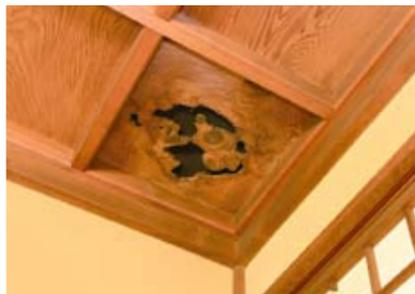
応接棟2階の天井部分。神社仏閣の天井を模したもの。ケヤキの自然な節穴を四隅に配すことで、板厚を見せて換気も兼ねる。
