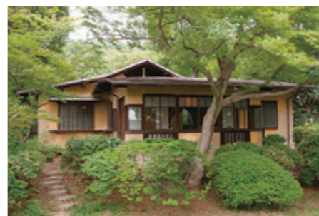
水平線を強調した南側外観。日射調整を考え、庇は1mと深く、勾配も緩やか。妻面には排気用の通風窓が設けられている。
