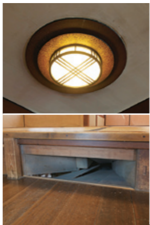
写真上 / 居室の天井埋め込み形の照明。藤井自身のデザイン。写真下 / 約30cmの畳の段差に設けられた導気口。中に埋設された導気筒を通して外気を取り入れる。
