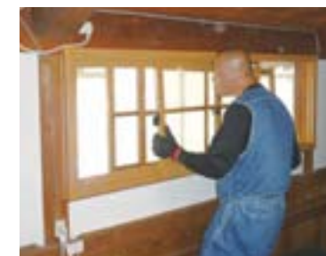
お客様の要望により断熱窓をリフォーム
