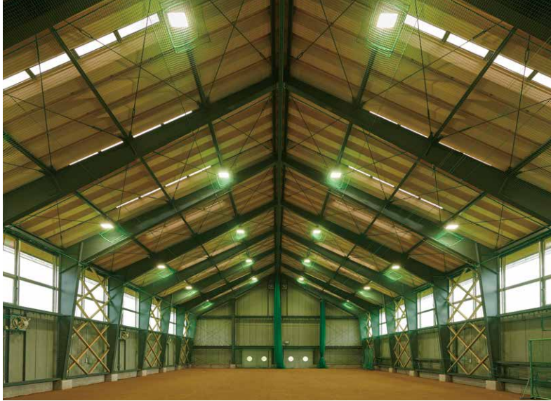
高天井用照明器具に加え、舞い上がる砂塵を排出する換気設備も備えた屋内練習場
