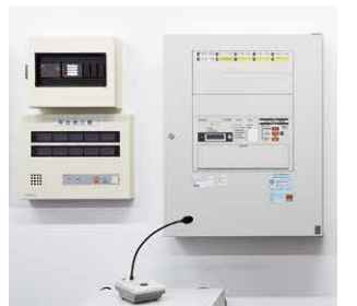
P型1級受信機(右)と業務放送設備
