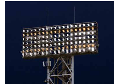
従来のカクテル光線をLEDで再現した鉄塔照明
