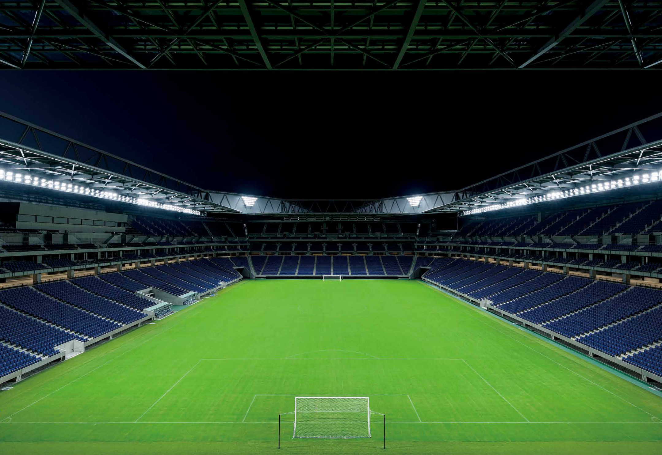
中角・広角配光の投光器を分散配置することで、見上げた際のグレアを軽減
