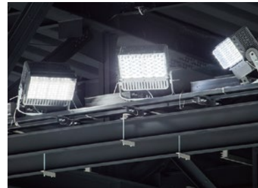
FLAT HACHINOHEの用に開発されたLED照明器具。 設置の向きや照度を1台ごとに調整した
