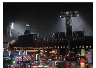
精緻な配光制御で周辺への光漏れを抑制
