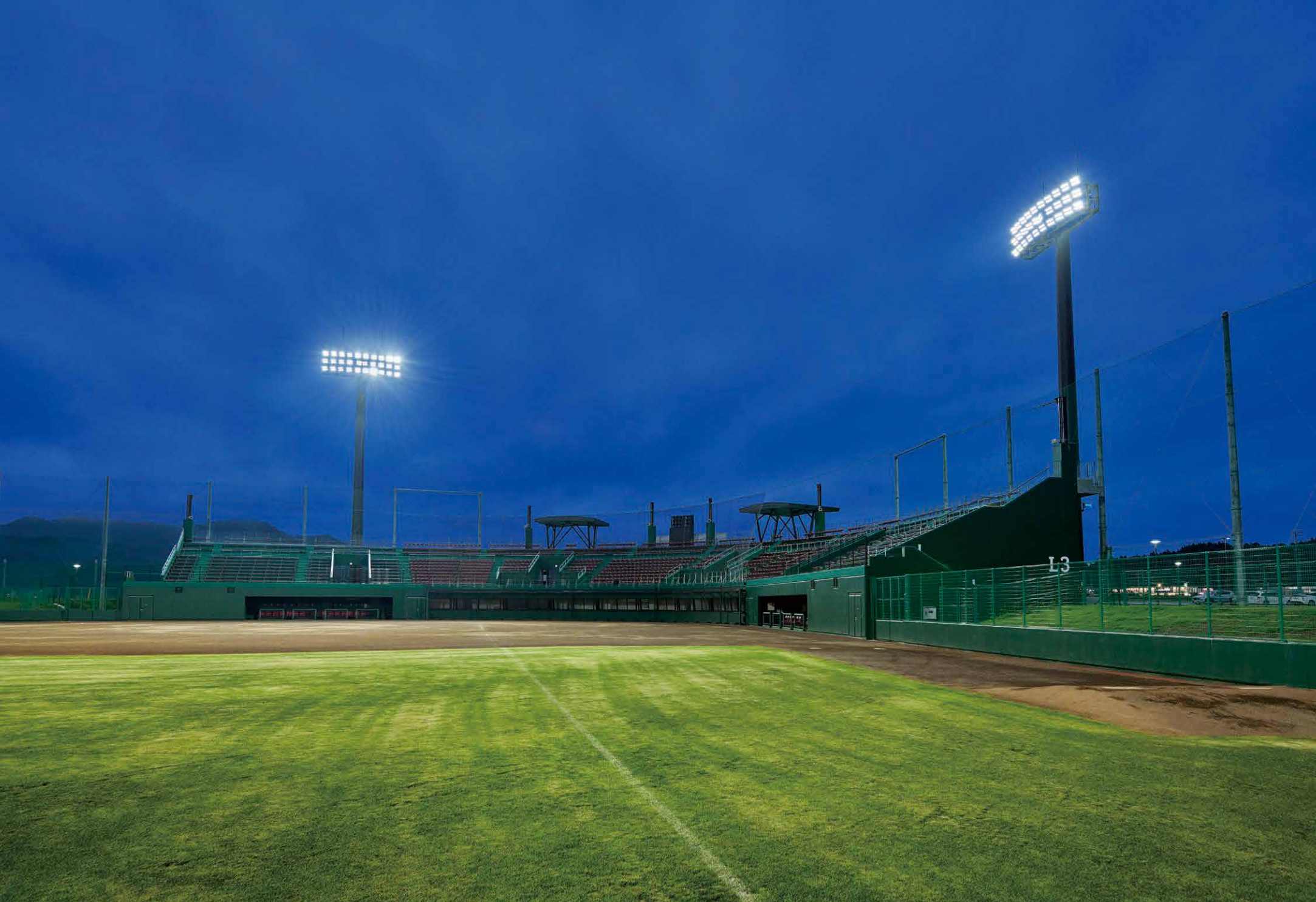
第一野球場のLED投光器は硬式野球・一般競技で内野750lx、外野500lx。硬式野球・レクリエーションで内野500lx、外野300lxなど3段階に照度レベルが切り替え可能
