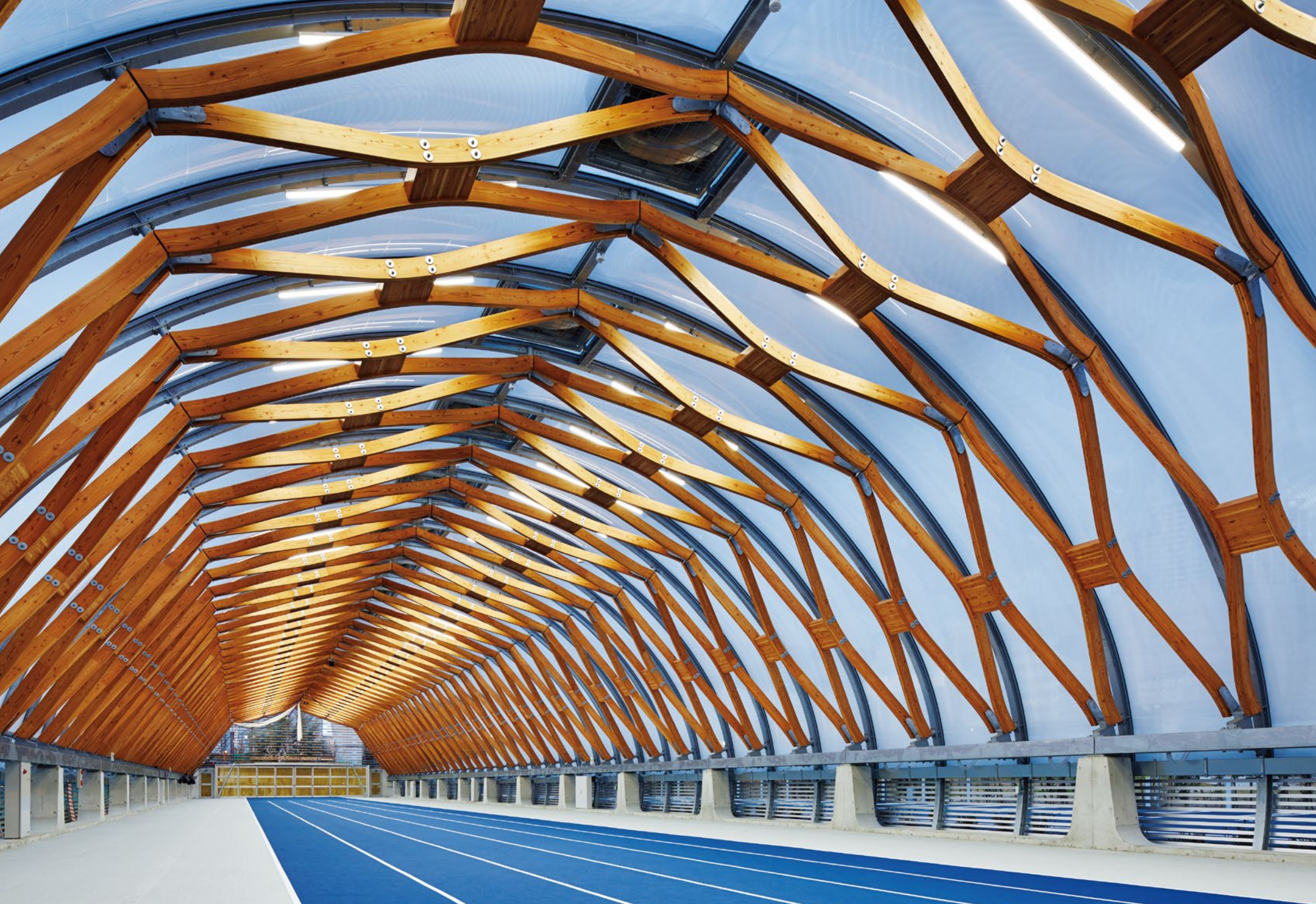
6レーンの60mランニングトラックは一体型LEDベースライトiDシリーズによって夜間練習環境としての平均照度500lxが確保されている
