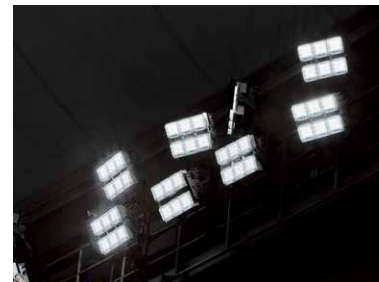
DMX制御が追加された大光束（86,000 lm）のLED投光器
