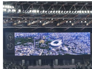
約9m×約36m（塔時計、45分計、ランニングタイマー部分の4mを含む）の大型映像装置
