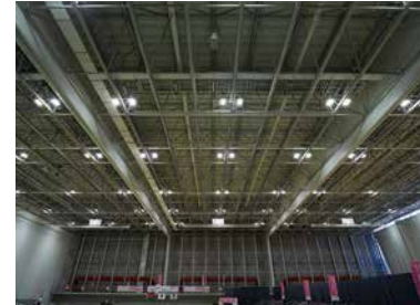
PiPit調光システムによるアリーナ3/4の100%点灯
