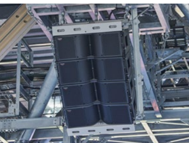
8連式×24基、4連式×14基のラインアレイスピーカーが均一で明瞭な音を伝える。ラインアレイスピーカー8連式（左）、ラインアレイスピーカー4連式
