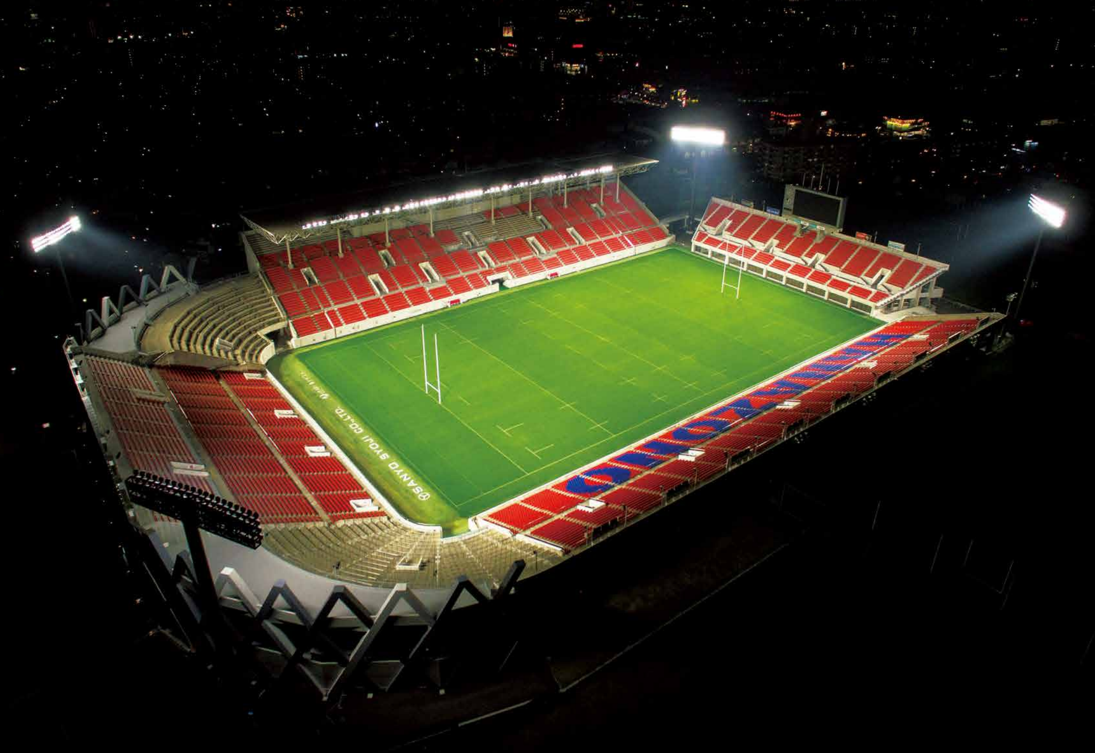
グラウンドの四隅に設けられた照明塔と、メインスタジアム上部に設置された合計381台のLED投光器（マルチハロゲン灯Sタイプ2000形相当）
