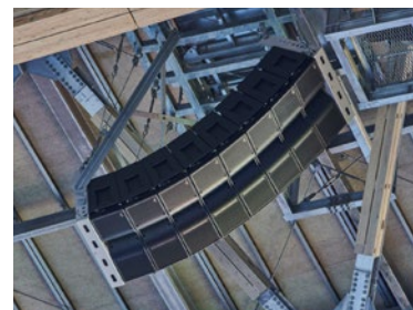
8連式×24基、4連式×14基のラインアレイスピーカーが均一で明瞭な音を伝える。ラインアレイスピーカー8連式（左）、ラインアレイスピーカー4連式
