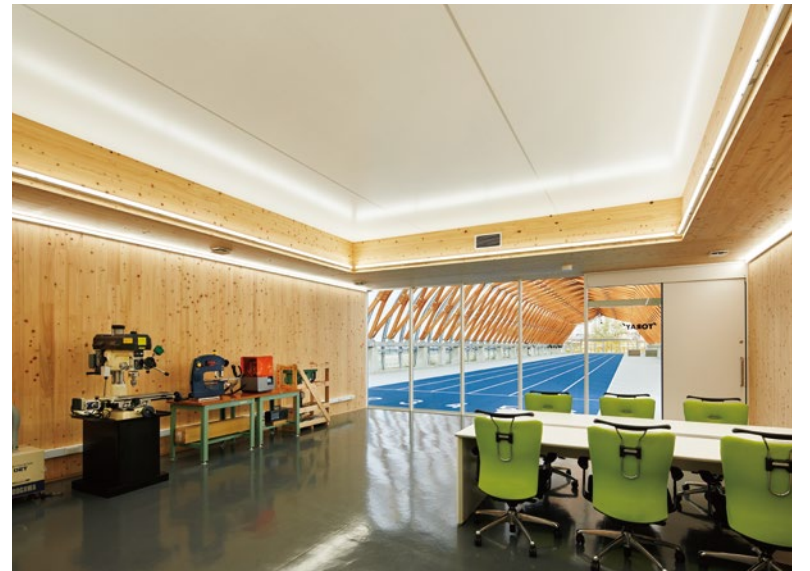
檜と杉によるCLT※2を構造材として用いたオフィス。檜の美しい表情をライン照明が際立たせている © 株式会社ナカサンドパートナーズ
