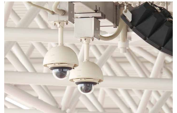
スタンド軒下に設置された4K/HDインテグレートカメラ
