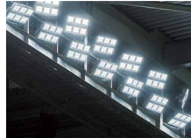
両サイドのキャットウォークに配置された モジュールタイプLED投光器
