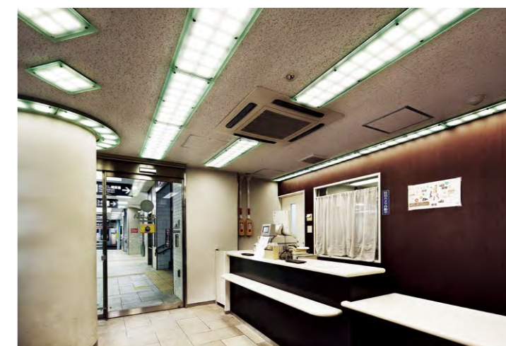
有機EL照明器具が設置されたシースルー改札口
