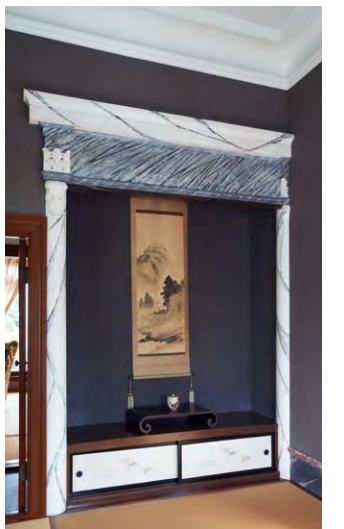
大理石のように見える漆喰の床柱と落とし掛け。優れた左官技術が求められる
