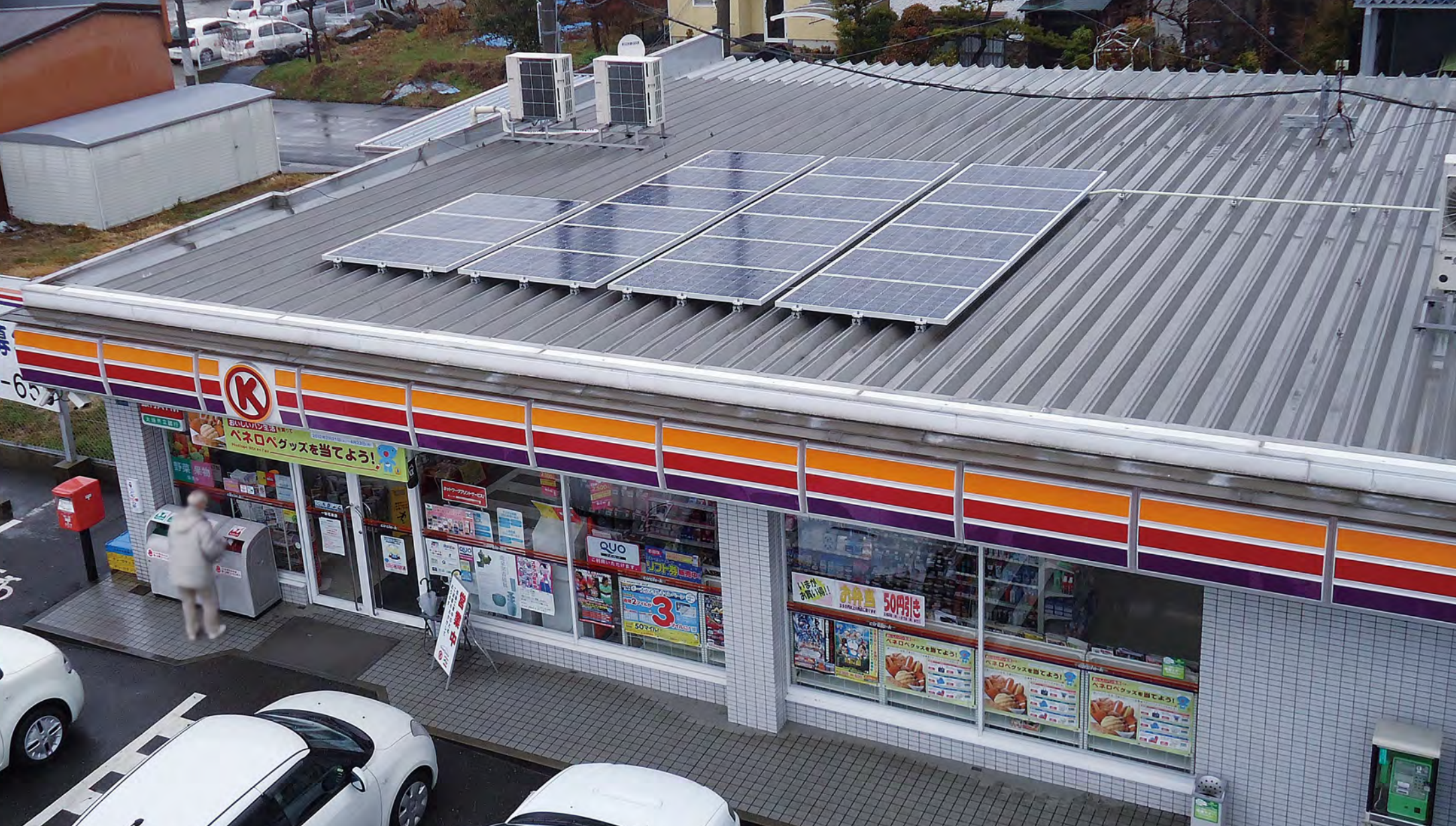
店舗屋上に設置された4.77kWの太陽電池モジュール
