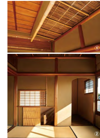
① 茶室の駆け込み天井に似た次之間の天井 ② にじり口、火灯口を模した2階入り口付近
