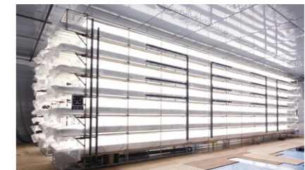
稼働を待つ2期工事ゾーン
