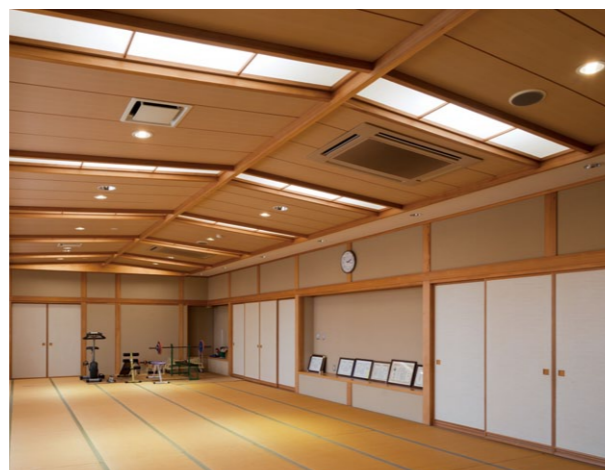
災害時には避難住民を収容する研修談話室
