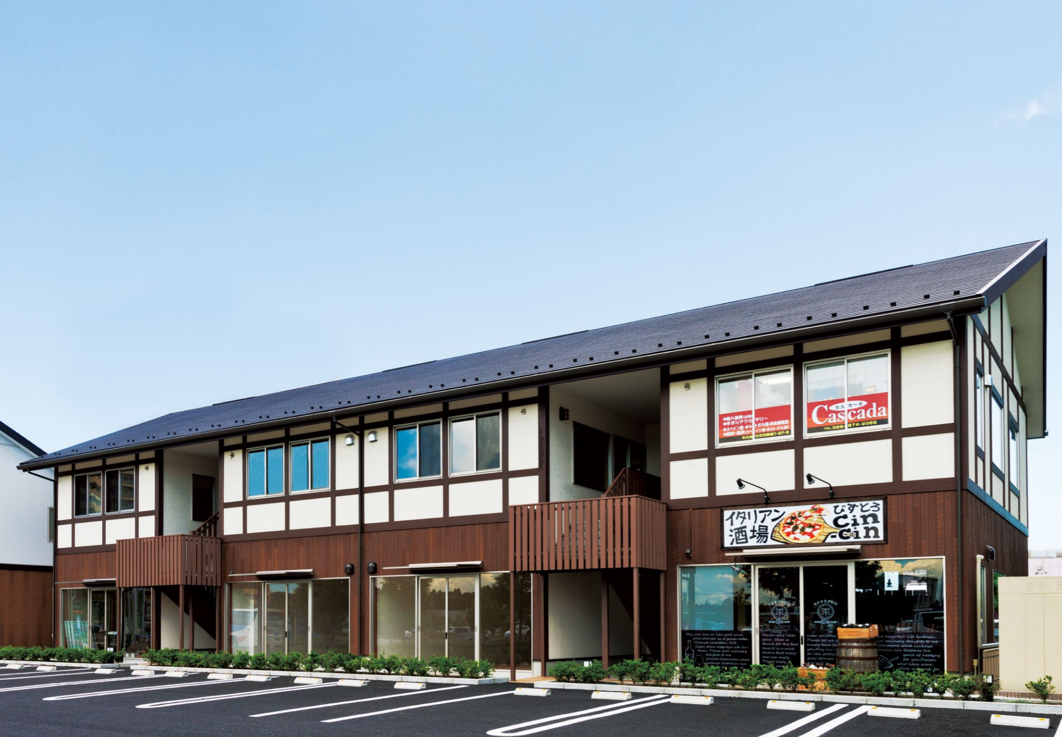
1階テナントの開口部は<テクノビーム>の採用により幅4,500mmを確保
