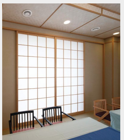
■平安会館(愛知県) 設置場所:食堂 設置台数:5台
