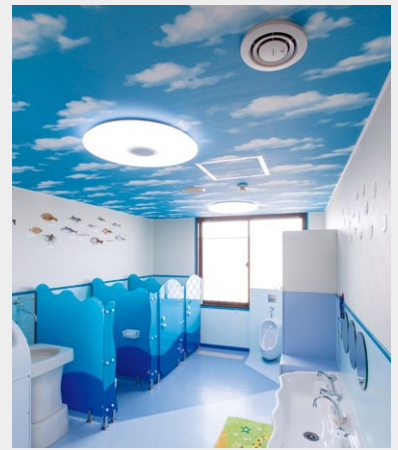
■良友会 あゆみ保育園(滋賀県) 設置場所:トイレ、保育室 設置台数:10台
