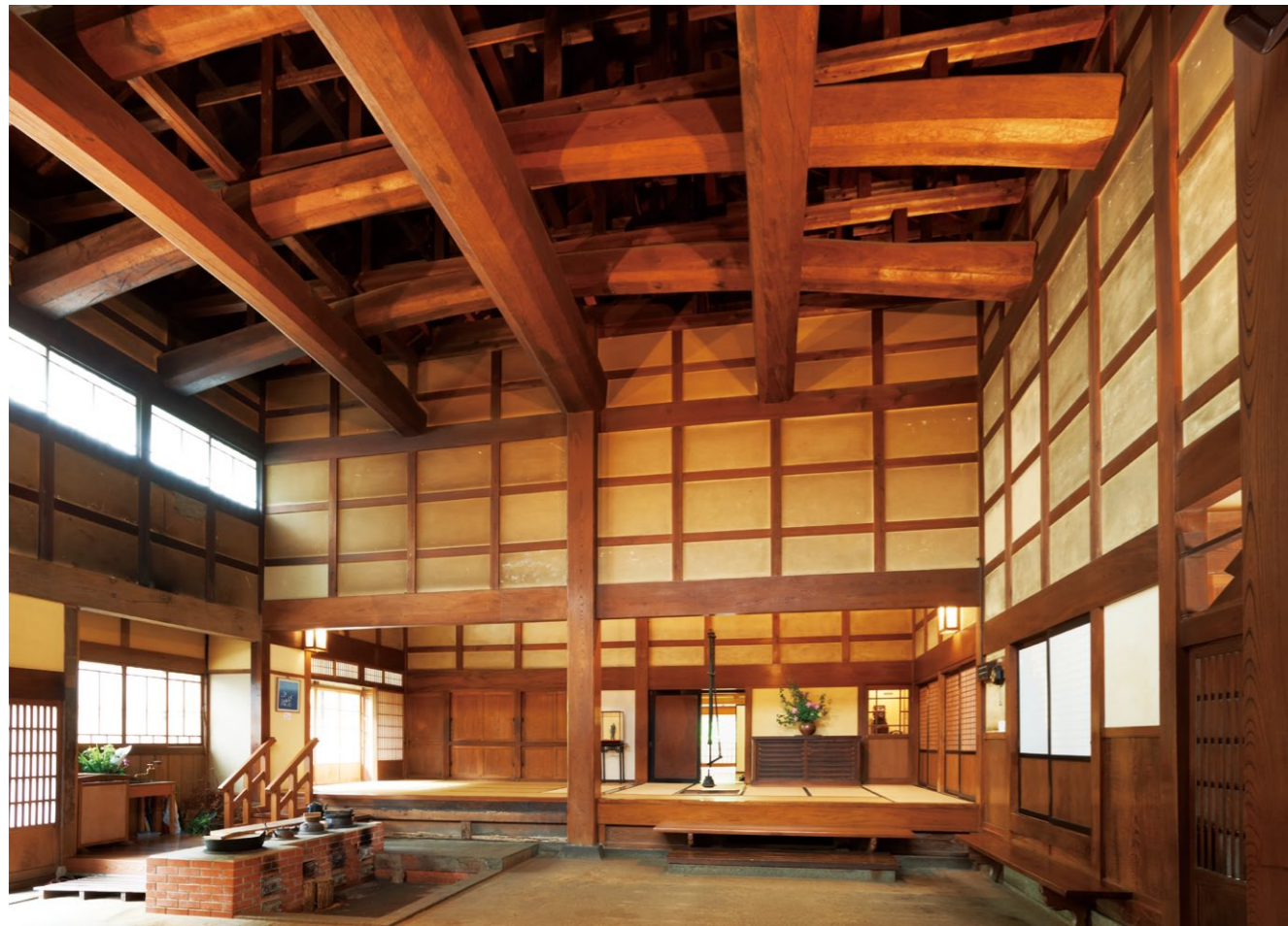
材木のショールーム的な役割を担った土間。当時には珍しい明かり取りの光で巨大な梁がよく見える。赤松やケヤキ、クリなど、良質な木肌が客の目に止まったであろう
