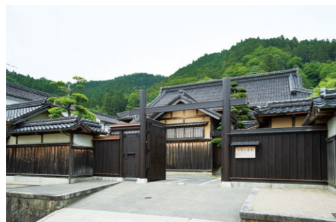
因幡街道から見た石谷家住宅。主要な建物は主屋や7棟の蔵を含め20棟余。屋敷後方の山をはじめ、広大な山林を所有していた
