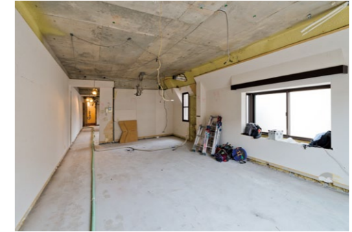
改修前 工事中の同一間取りの専有部(Eタイプ)
