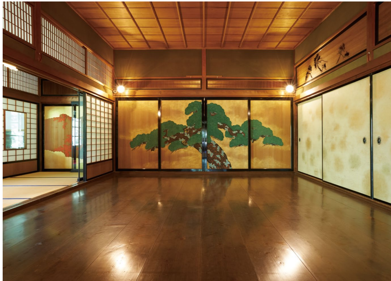
本格的な構造を備える大広間の能舞台。近代に私宅内につくられたものが良好に残されている例は少なく、貴重である。畳や敷居は可動式で部屋は座敷としても使用できる
