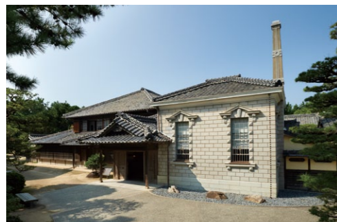
居室棟(左)と洋間。洋間は基礎構造が木造の擬洋風建築で、組石に見える外壁はモルタルの洗い出し(下部3段は御影石)
