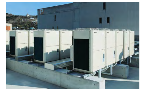
空調室外機<PAC>51台(計690HP)を設置
