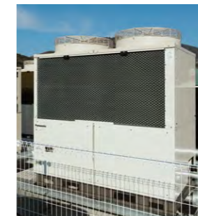
中国・四国地方のスーパー初となるノンフロン冷凍機
