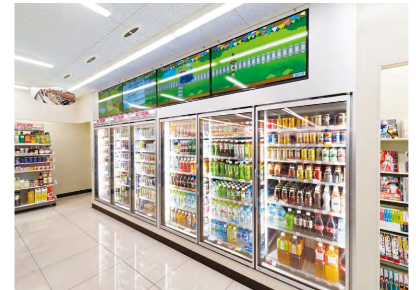
ケース照明に彩光色LEDを採用したノンフロン冷蔵庫と、42インチ4面のデジタルサイネージ
