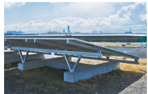
埋立地の局所沈下に対応する地盤掘削が不要なH型基礎
