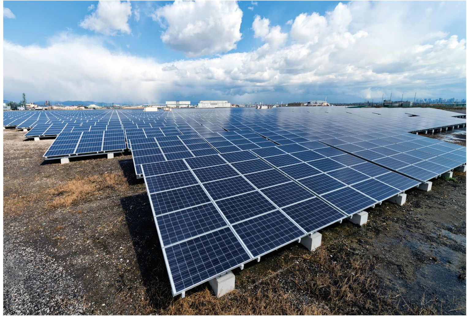
広大な敷地における配置効率を考えて設置角度10度に設定された太陽電池モジュール
