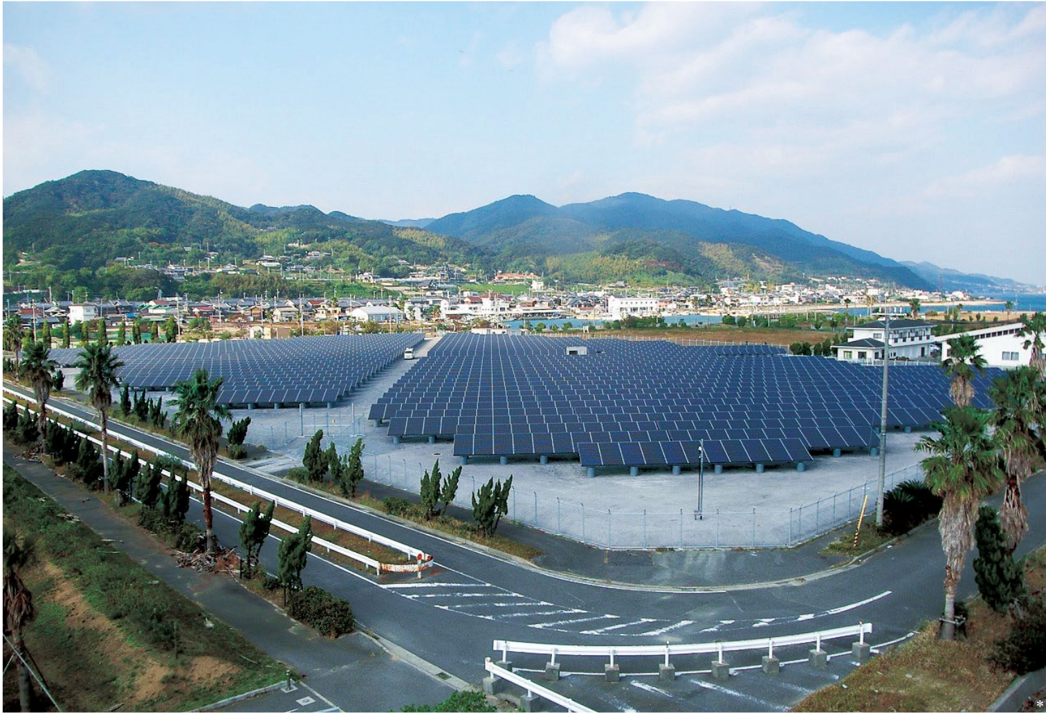
南東方向に向いた土地に効率的に配置された太陽電池モジュール「HIT」
