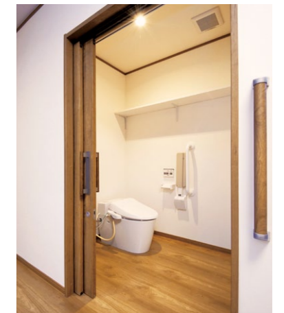
車いす利用にも配慮した3枚引き戸のトイレ
