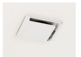
熱気調システムの屋内側空気供給口
