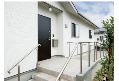
車椅子に配慮した玄関口のスロープ
