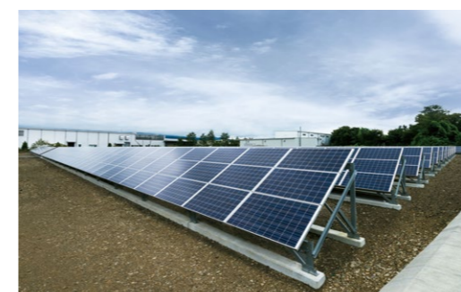
3,600枚の太陽電池モジュールを設置
