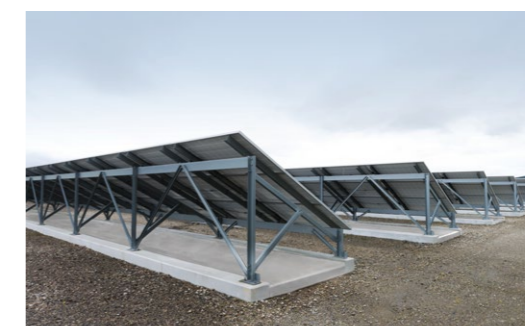
耐候性に配慮して地中に一部が埋め込まれたコンクリート製基礎
