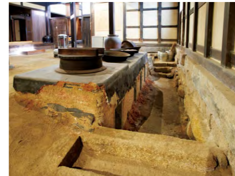
炊事場。かまどのたき口は土間を掘り込んだ位置にある。石を粗く積んだ壁から入る海風を利用して火を保つ仕組み
