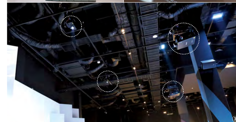
①大自然の映像がプロジェクションマッピングされる「ベースキャンパス」 ②映像により姿を変えるオブジェ ③大壁面のプロジェクションマッピングを実現する4台のプロジェクター
